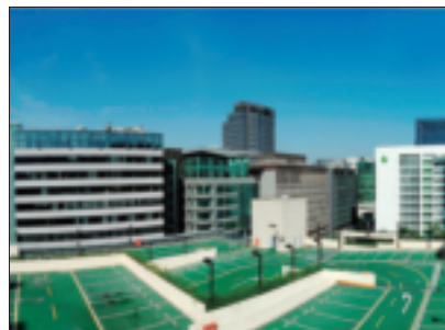
內湖洲子立體停車場頂樓安靜清幽，干擾少收音佳，是熱門拍攝地點。(圖／臺北市電影委員會提供)
