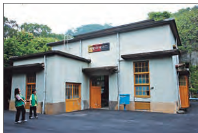
位於天母古道入口左側的三角埔發電所。
