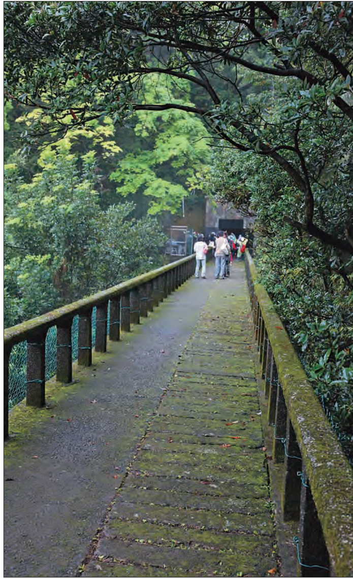
草山水管橋的橋面設計大有玄機。
