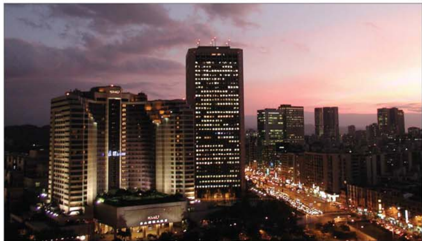
未開發前的信義計畫區是一片空曠的荒野（上圖），現在已躍升為臺北市的行政及商業重鎮。（下圖）
