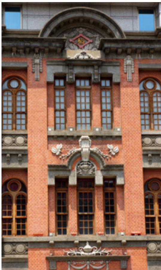
葉厝外牆立面上可看到許多繁複華麗的花草水泥浮雕。 (高讚賢攝)
