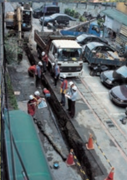
配水管汰換更新工程，確保供水品質。 (高讚賢攝)
