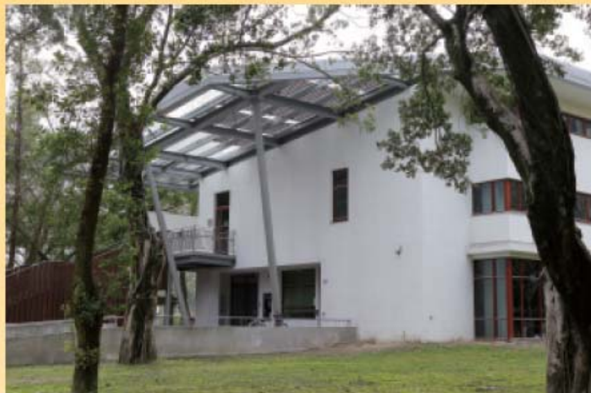
太陽圖書館的屋頂使用太陽能板吸收光熱發電，節能又環保。
