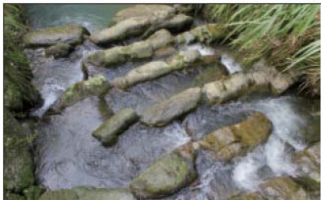
利用生態工法跌水工（魚梯），避免水流侵蝕溪岸，讓小坑溪變得更加安全。
