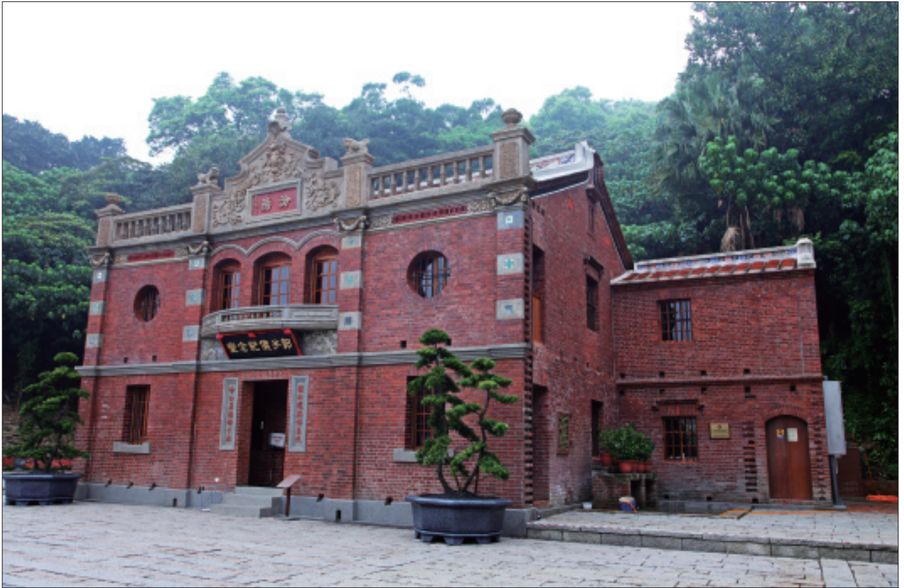
俗稱「內湖紅樓」的郭子儀紀念堂，坐落在小丘山腰上，坐北朝南，外觀為閩南式搭配巴洛克式混築的雙層磚造樓房。
