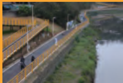
景美溪右岸「最後一哩」自行車道完工，將全市111公里的河濱自行車道全線串連起來。
