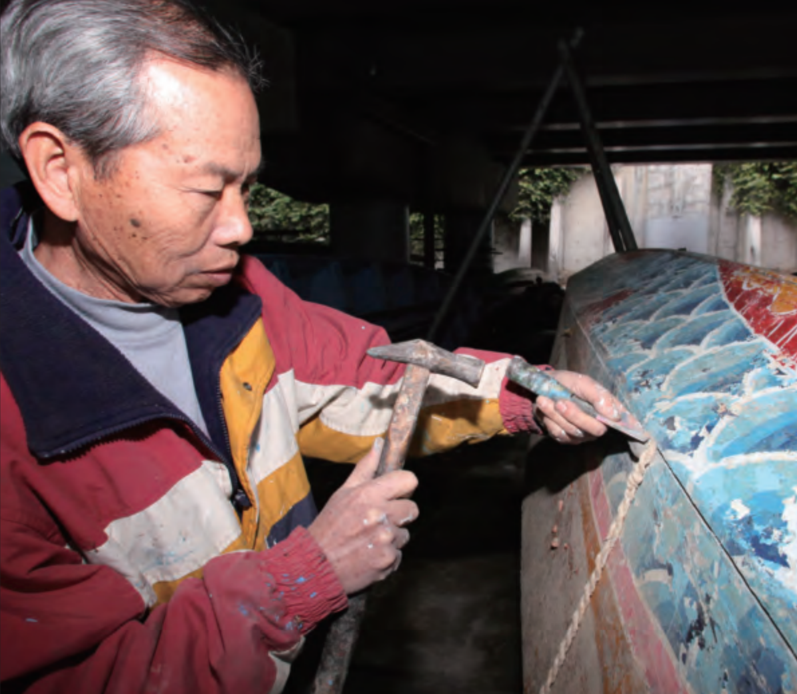
阿正師示範龍舟補漏工法：將繩子敲進船體縫隙中，再灌進桐油黑或AB膠，即可防止龍舟滲水。（王能佑攝）
