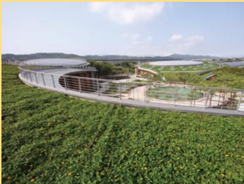
新生三館的屋頂層覆土植栽降低室內溫度，加上牆面綠化，預估可減低室內溫度攝氏4至6度。
