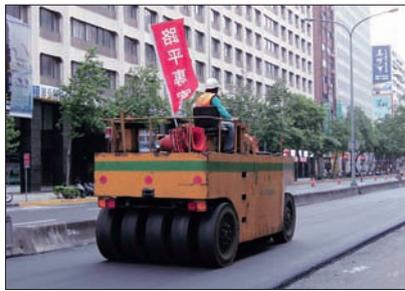
以膠輪壓路機來回滾壓，調整道路高標並確保品質。
