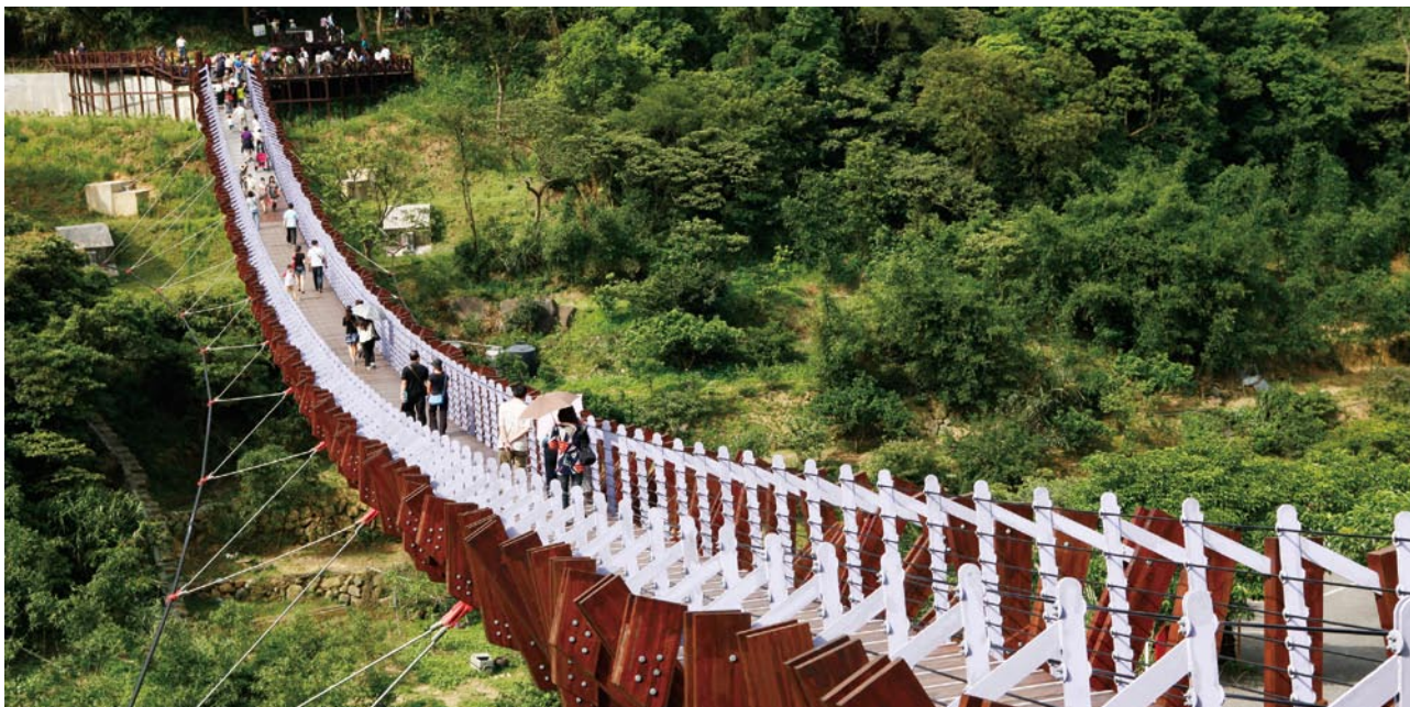
白石湖吊橋的龍骨造型不但全臺少見，更串聯了周邊的遊憩景點。
