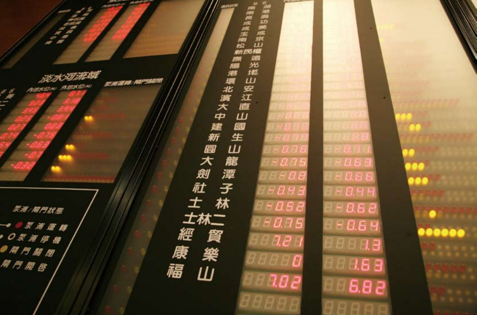
指揮作業中心設有提供抽水站運轉資料的大型螢幕。
