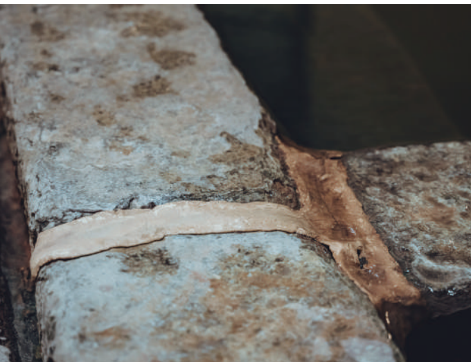
左：青磺泉的特性讓石砌浴池維持不易，每半個月就需補強石塊之間的縫隙。右：引進現代化管理措施，湯客需在櫃台報到後領取鑰匙進場。
